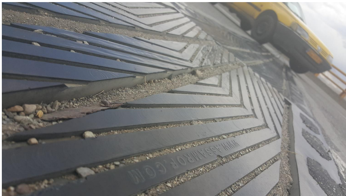
تهران جاجرود - درز انبساط RE-900 با جابجایی بیش از 20 سانتی متر - 1388
